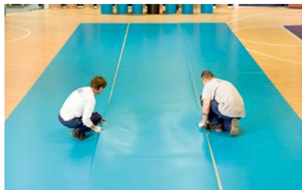
Pose revêtement sportif
