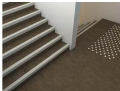
Réalisation de marches intégrales
