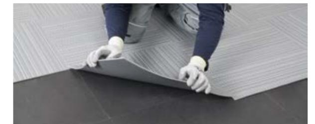
Mise en place des lames et dalles en pose libre si < 30 m<sup>2</sup>
