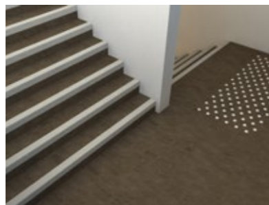
Réalisation de marches intégrales
