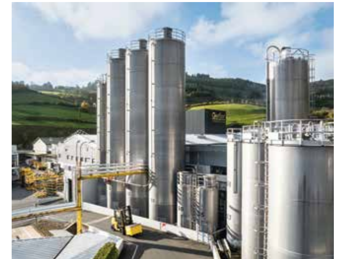
↑ Des sites modernisés pour réduire nos consommations d'énergie. Usine Gerflor Tarare, France.
