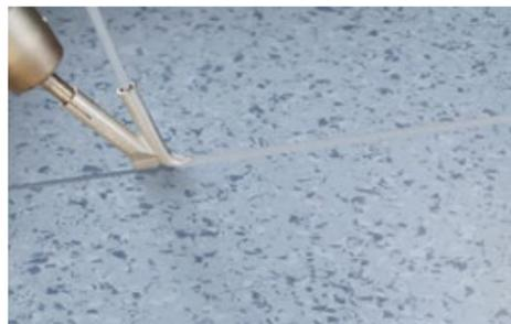
Le cordon est positionné dans le chanfrein entre les deux revêtements. En le chauffant, il fusionne avec le revêtement et garantit une étanchéité parfaite
