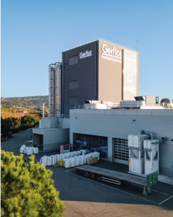
↑ Usine Dalles et Lames, Saint-Paul-Trois-Châteaux, France.
