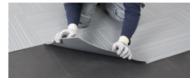
Mise en place des lames et dalles en pose libre si < 30 m 2
