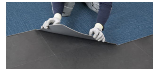
Mise en place des lames et dalles
