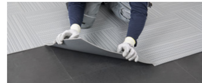
Mise en place des lames et dalles en pose libre si < 30 m²
