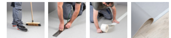
1. Nettoyer et marquer l'emplacement
