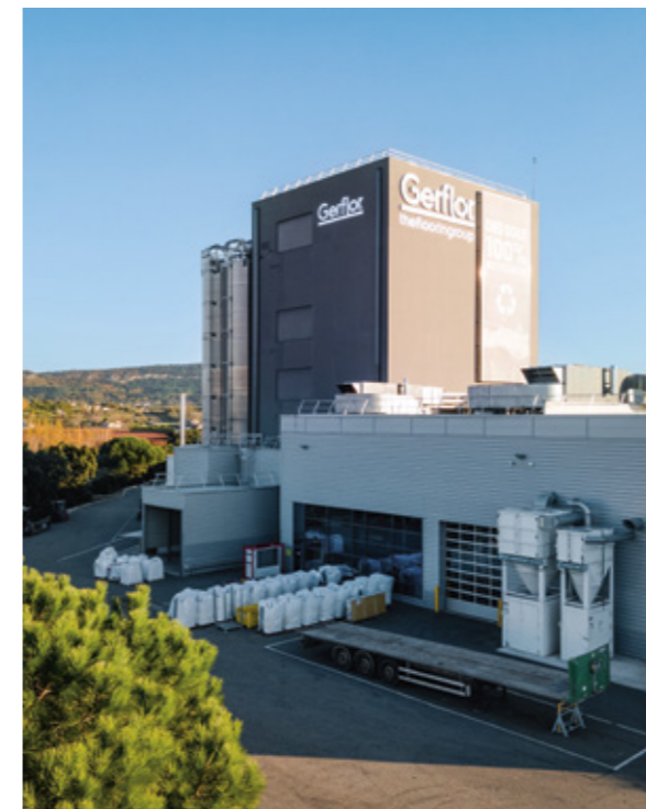
↑ Usine Dalles et Lames, Saint-Paul-Trois-Châteaux, France.
