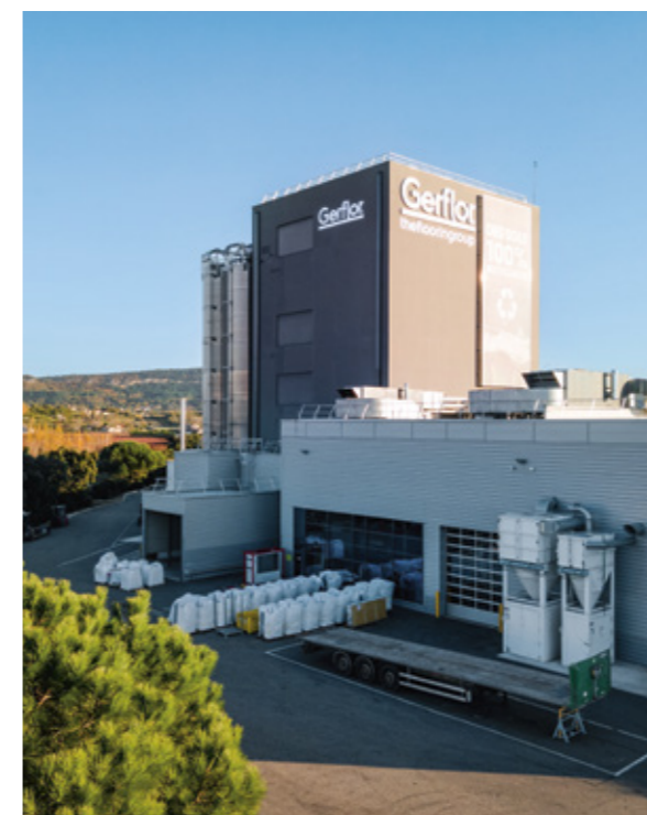
↑ Usine Dalles et Lames, Saint-Paul-Trois-Châteaux, France.
